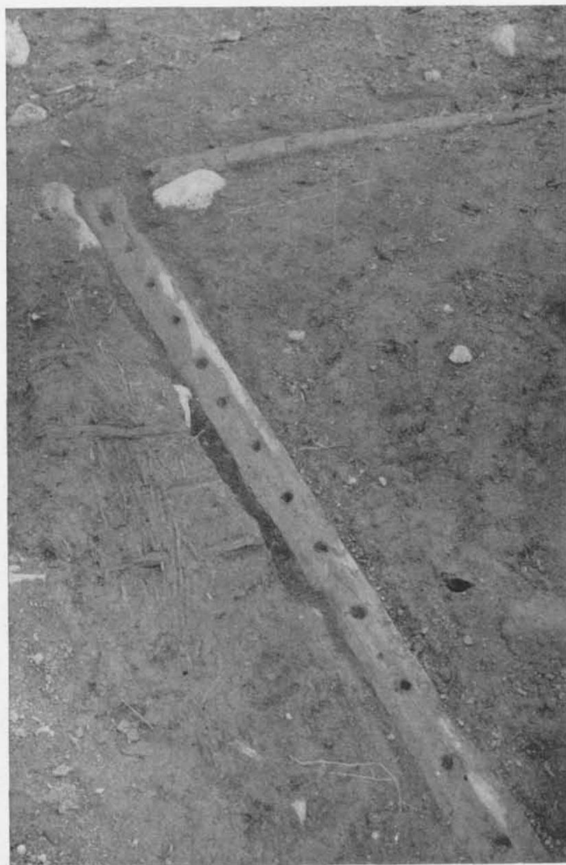
Fig. 130. Klenhusets Ö syll med kullfallna väggen.
