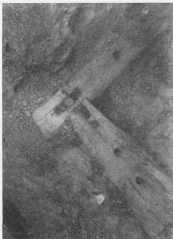
Fig. 129. Klenhusets NV hörn (med hål för störrarna, tapphål i hörnet med dymlingarna ännu bevarade).
