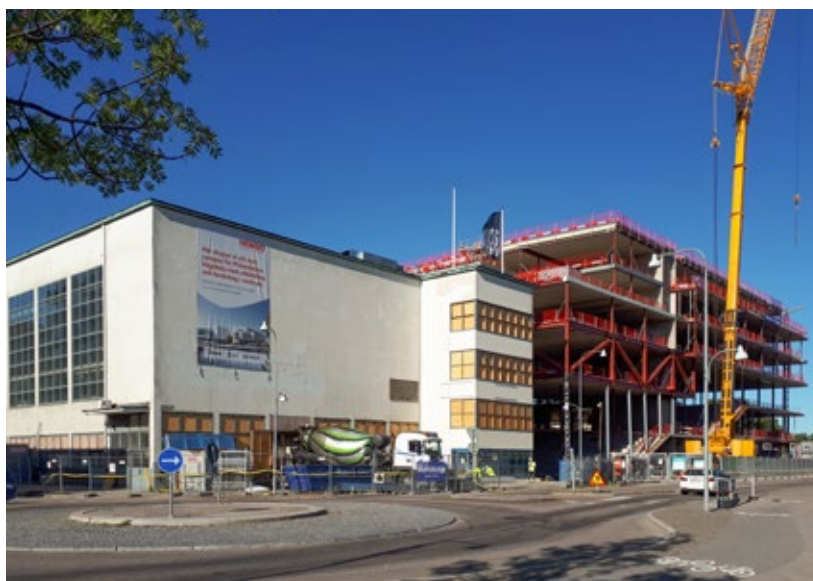
Bild 2. Pågående byggnation av Mälardalens högskola med det gamla badhuset till vänster. Bilden togs i samband med att intervjuer genomfördes med Eskilstuna kommun den 21 augusti 2018. Foto: Evelina Stadin/RAÄ. Bilden är något beskuren.
